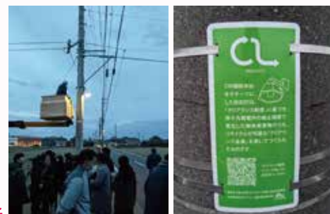
クリアランス防犯灯点灯の様子
